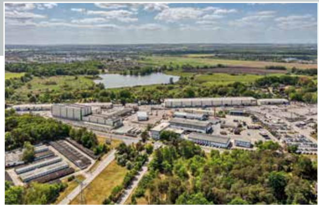
BUTTING Anlagenbau in Schwedt
