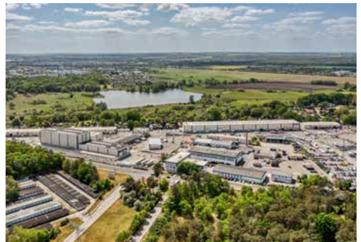
BUTTING Anlagenbau in Schwedt 2025
