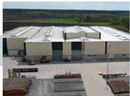
2021 Bau und Inbetriebnahme der zweiten BuBi® Fertigungslinie in Kneesebeck
