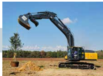
2025 In Loxley, Alabama entsteht ein neuer BUTTING-Standort für moderne Rohrtechnik
