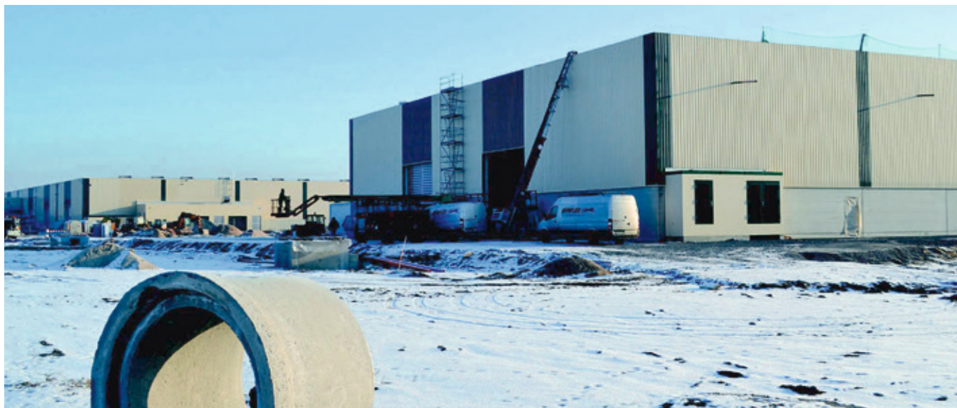
Investitionen sind sehr motivierende Veränderungen! 50 x 150 m Hallenfläche zur Erweiterung und Optimierung unserer 12-m-Blechrohrfertigung; geplante Fertigstellung ist Mai 2012
