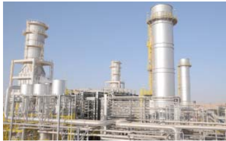
HRSG Project for NeM/Oxy Mukhaizna
