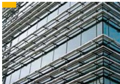
Bild 32: Dekorationsrohre am Hochhaus
